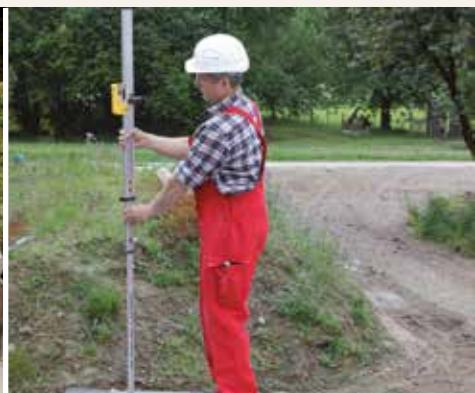
7.1.3 Aby bylo možné stanovit minimální výšku vrstvy malty, zjišťuje se nejvyšší bod betonové desky pomocí nivelačního přístroje nebo hadicové vodováhy.
