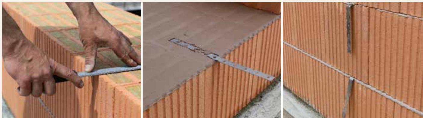
**7.6.1** Aby při použití stěnových spon z ploché oceli nedošlo ke zvětšení tloušťky ložné spáry, je vhodné v místě vložené spony cihly lehce probrouosit keramickým pilníkem či poklepat zednickým kladívkom o cca 1 mm.
