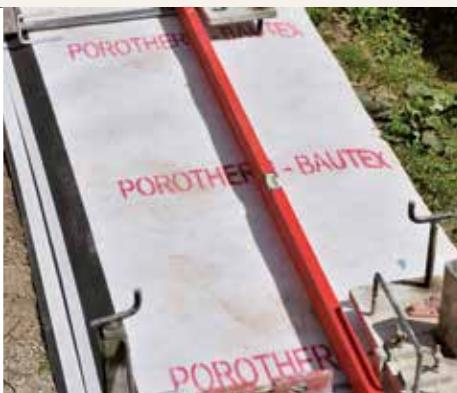
7.1.2 Proti vznikání vlhkosti se pokládá v místě budoucí vyzdívy hydroizolační fólie (např. Porotherm ZIP - S).
