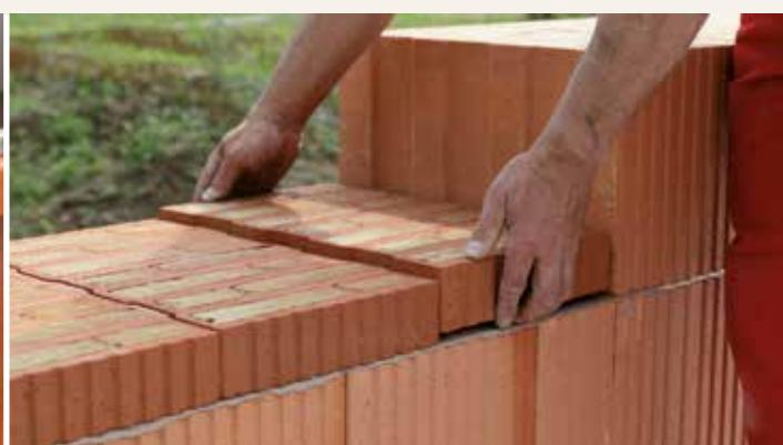
7.5.2 Vyrovnávací cihly např. v oblasti okenního parapetu zabránění tepelným mostům.
