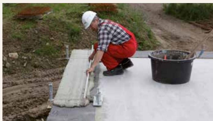
7.1.7 Malta se urovná stahovací latí na vodicích lištách vyrovnávací soupravy.
