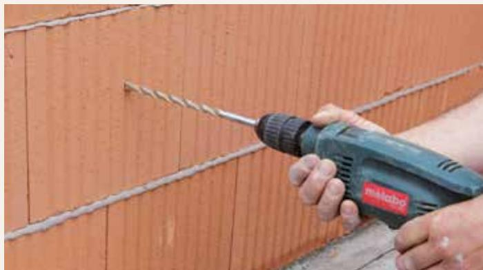
7.11.4 Vrtání bez příklepu s ostře nabroušeným vrtákem z tvrdokovu.
