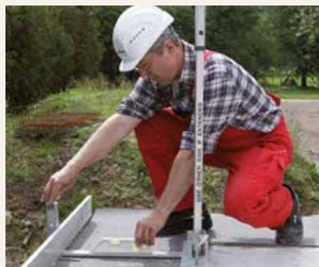
7.1.4 Pro přesné výškové uložení zakládací malty se používá vyrovnávací souprava (viz program produktů Wienerberger).
