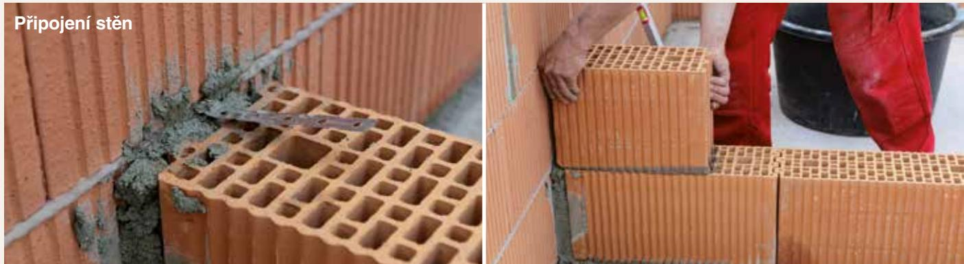
**7.6.4** Když se provádí připojení ke stěně, ohněte kotvu vždy směrem nahoru.
