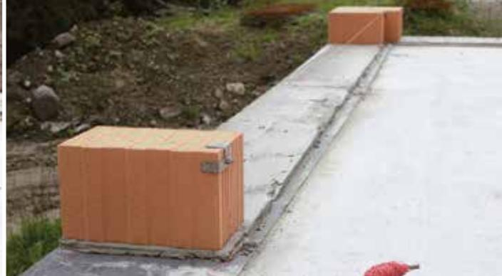
**7.2.2** Se zděním obvodových stěn se začíná v rozích osazením rohových cihel. K nim se přikládá vodicí šňůra.
