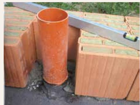
7.12.3 První vrstva cihel Porotherm 44 T Profi u vyzdívané drážky pro odpadní potrubí.
