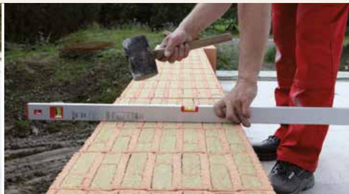
**7.2.4** Cihly se nakonec urovnají v obou směrech pomocí gumové paličky a vodováhy.
