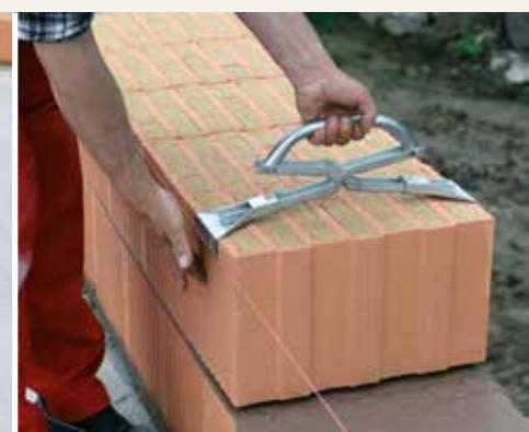
**7.3.6** Jako obvykle umístěte na začátku a na konci řady jednu cihlu a k nim přiložte zednickou šňůru. Potom pokládejte cihly na sraz tak, aby byl při spouštění do vrstvy malty slyšet jejich skřípot.
