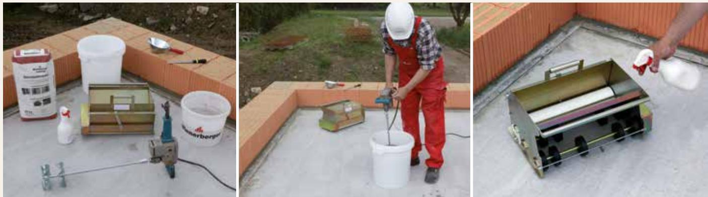
**7.3.1** Potřebný materiál (podle programu produktů Wienerberger): tenkovrstvá malta, čisticí sprej (separační prostředek), vědro pro rozmíchání, maltovací vozík, vědro na vodu, mísidlo, fanka, pilník.
