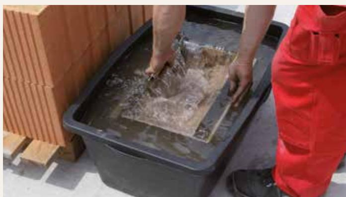
**7.3.7** Během delších přestávek v práci položte prázdný vozík do vodní lázně. Tak malta na něm nezaschně. Pokud se má opět pokračovat, vodu z maltovacího vozíku jednoduše vytřeste.
