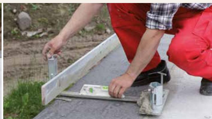
7.1.8 Poté se jeden přípravek vyrovnávací soupravy přesune o délku stahovací latě a znova vyrovná.
