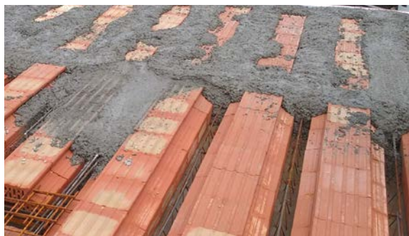
Betonáž stropu
