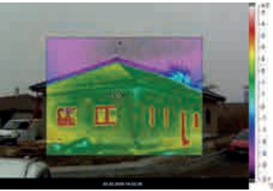
Termovizní snímek domu
