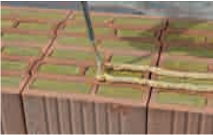
Způsob nanášení lepidla pro zdění Porotherm Dryfix.extra
