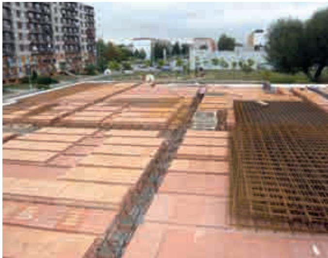
Keramický strop Porotherm u bytového domu s celoplošnou nadbetonávkou ještě před betonáží
