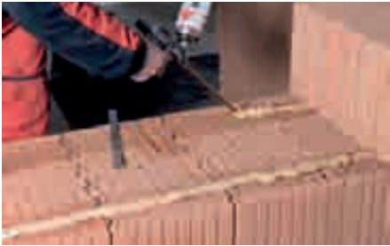
Způsob nanášení zdicí pěny Porotherm Dryfix
