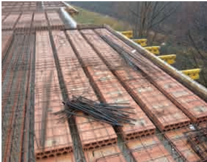
Keramický strop Porotherm u bytového domu s celoplošnou nadbetonávkou ještě před betonáží
