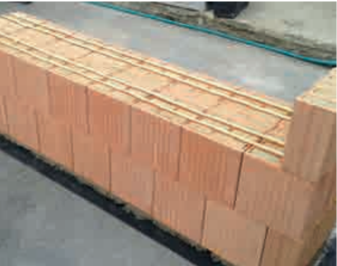
Moderní způsob zdění pomocí lepidla pro zdění (Porotherm 44 T Profi Dryfix)
