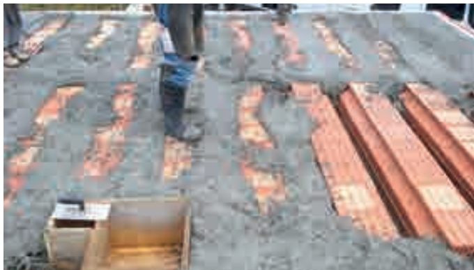
Betonáž keramického stropu Porotherm BN bez celoplošné nadbetonávky
