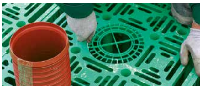
Vývod potrubí dn 200 mm
