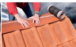
Vytvarujeme pás dle krytiny.
