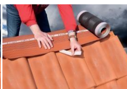
Odstraníme separační pásky z lepicí vrstvy WCS.
