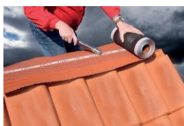
Větrací pás přichytíme k latě.
